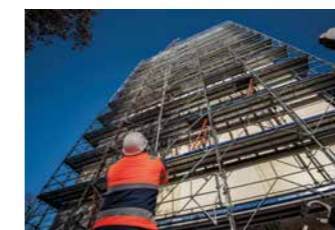
Travaux préparatoires à la démolition d'un bâtiment à Gennevilliers
