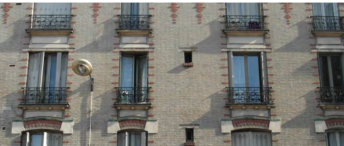
Bâtiments à matérialité
