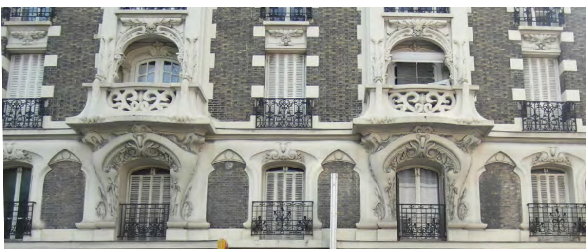
Bâtiment à modénatures
